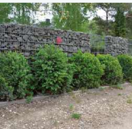
Ogrodzenie na froncie wykonano z ocynkowanych przęsł i gabionów wypełnionych bazaltem.
