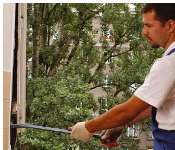
Za robociznę przy wymianie okien zapłacimy więcej niż za montaż w nowym domu. OKNOPLAST
