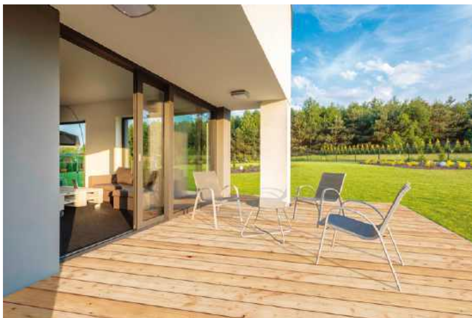
🔗 Trwałość drewnianego tarasu w dużym stopniu zależy od gatunku zastosowanego drewna. Najtańsze jest rodzime, ale warto rozważyć zakup egzotycznego, które jest znacznie bardziej odporne na wilgoć, korozję biologiczną i ścieranie. dlh
