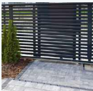
🔧 Furtkę (1 m) i bramę wykonano ze stali ocynkowanej, polakierowanej.
