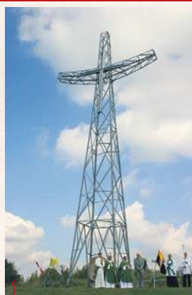
Krzyż energetyków, konstrukcja krzyża oparta jest na kratowym słupie energetycznym z poprzecznikiem, na wzór rozpiętych ramion Chrystusa
