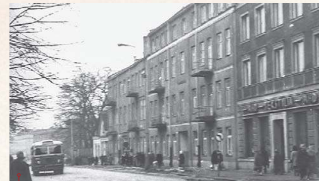
Odbudowane budynki mieszkalne przy ul. Lipowej
