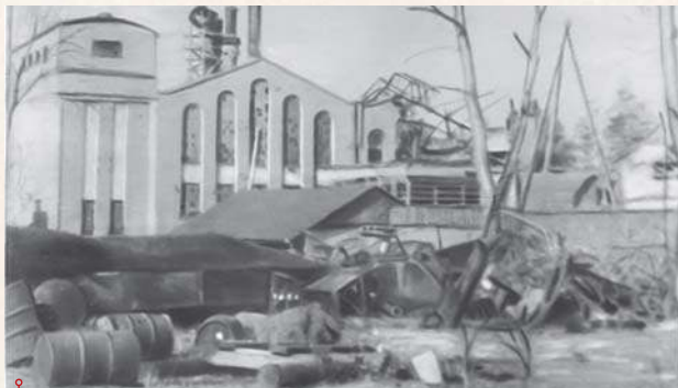
Widok zniszczonej elektrowni
