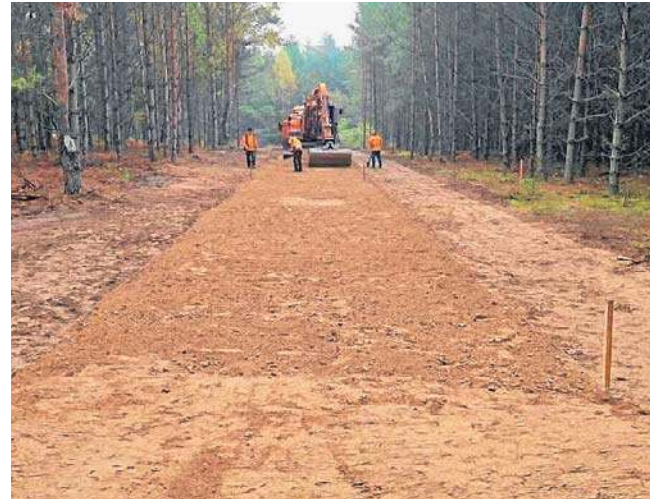
Trwa realizacja zadania inwestycyjnego pn. „Rozbudowa sieci wodociągowej i kanalizacyjnej w Gminie Narewka”
