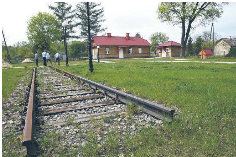
Centrum Edukacji Historycznej „Stacja Sobibór” w Sobiborze
