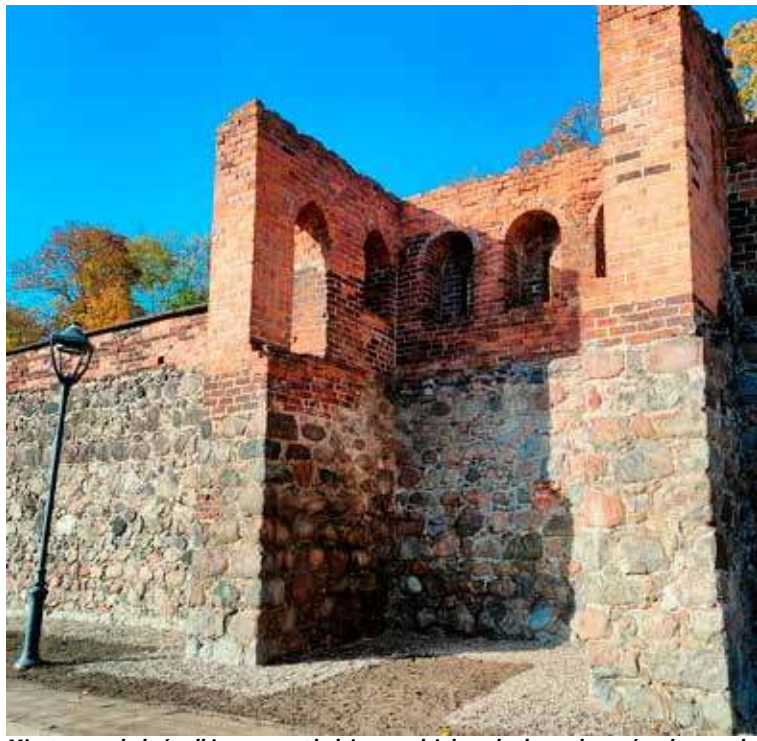
Miasto pozyskało środki na remont kolejnego odcinka zabytkowych murów obronnych
