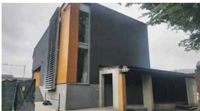
Budynki zaplecza, szatnie już stoją, nikt ich nie wyburzy.
