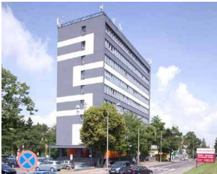
W biurowcu wykonany zostanie kompleksowy system przeciwpożarowy oraz remont holu
