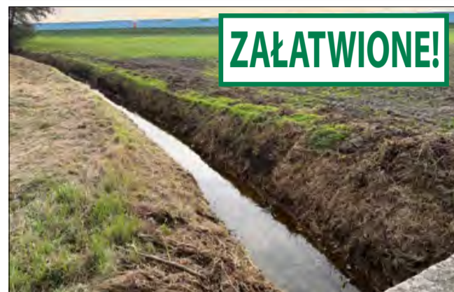
Rów został oczyszczony z zarośli. Teraz woda płynie swobodnie.
