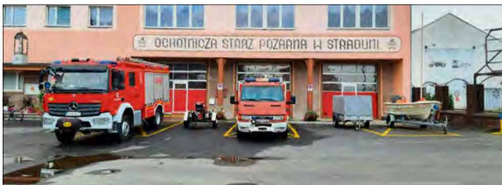
Gmina Walce modernizuje remizę OSP w Straduni i budynek wielofunkcyjny w Kromołowie.
