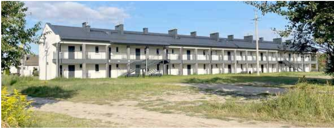
Dwupiętrowy budynek czeka na pozwolenie na użytkowanie
