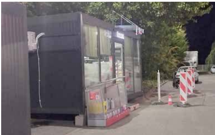
Obsługa pracuje obecnie w tymczasowych pomieszczeniach
