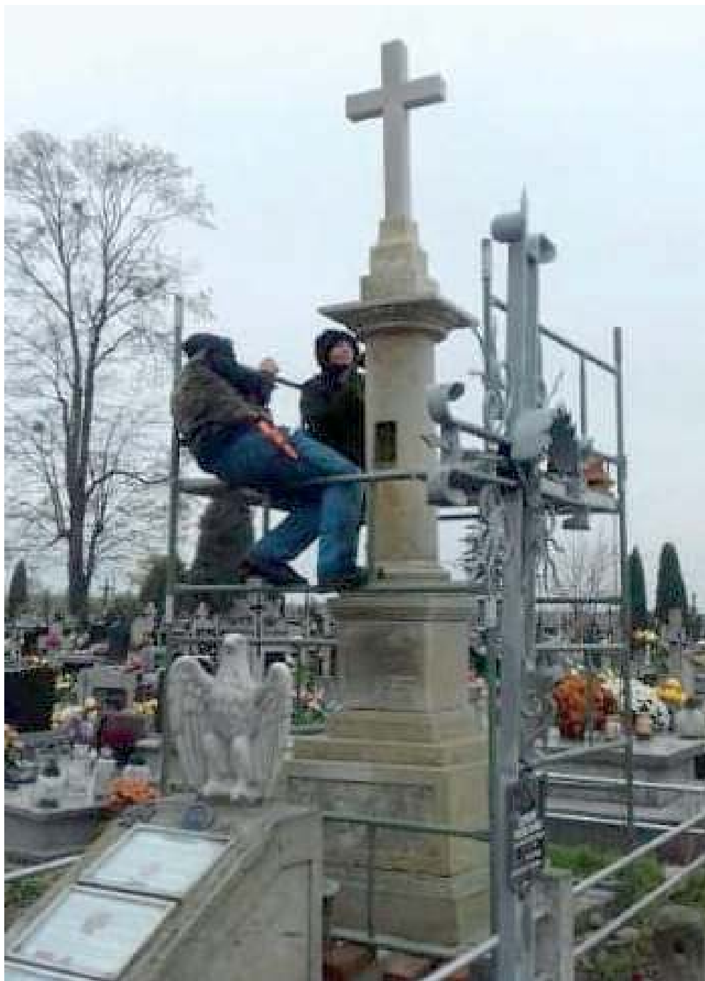
Prace konserwatorskie obejmują m.in. usunięcie wtórnych zapraw cementowych i przemalowań olejnych, rozebranie, rozbicie elementów konstrukcji betonowych zbrojonych, demontaż cementowego krzyża, oczyszczenie inskrypcji, montaż rekonstrukcji kamiennego krzyża
