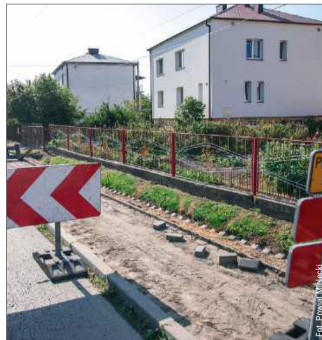
Przy powiatówce nr 1140R, powstaje nowy trakt dla pieszych
