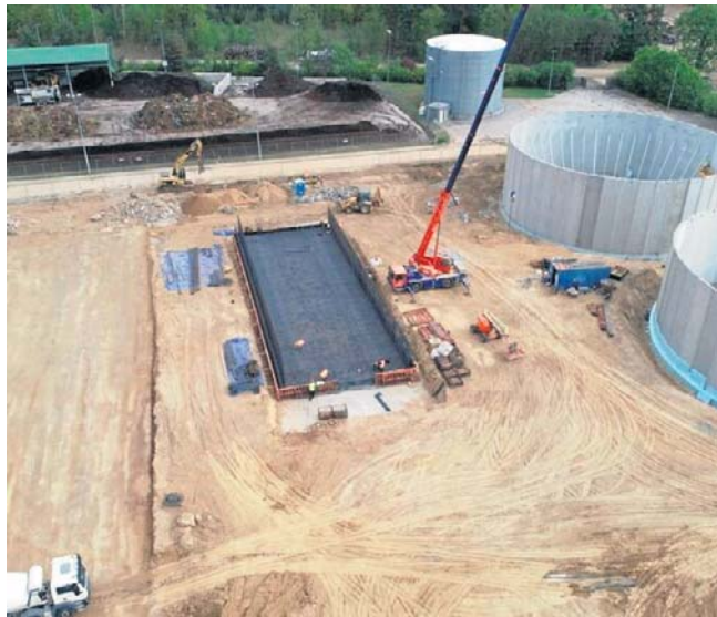
Budowa biogazowni pochłonie ponad 129 milionów zł
