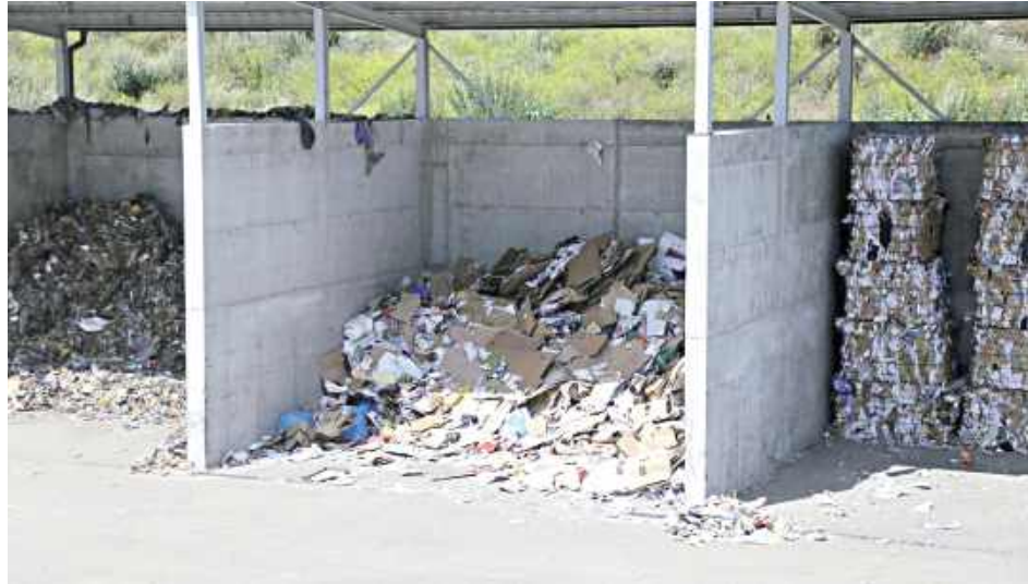
Zakład Zagospodarowania Odpadów w Korczowie
