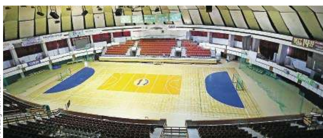
Hala Urania w Olsztynie została wybudowana w 1978 roku
