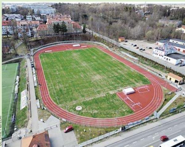
Zmodernizowany stadion w Mrągowie
