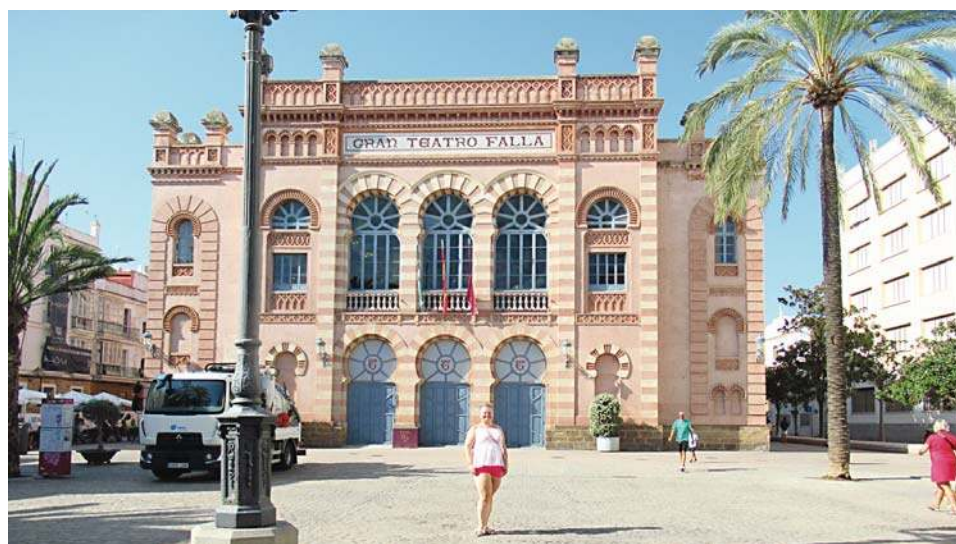
Gran Teatro Falla
