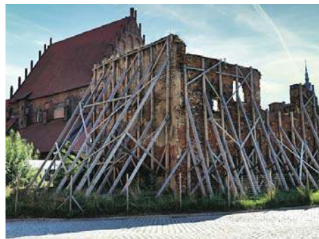
O krok bliżej do remontu Galerii EL | 3
