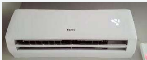
📍 Jedna z pięciu ściennych jednostek wewnętrznych w układzie multisplit.
