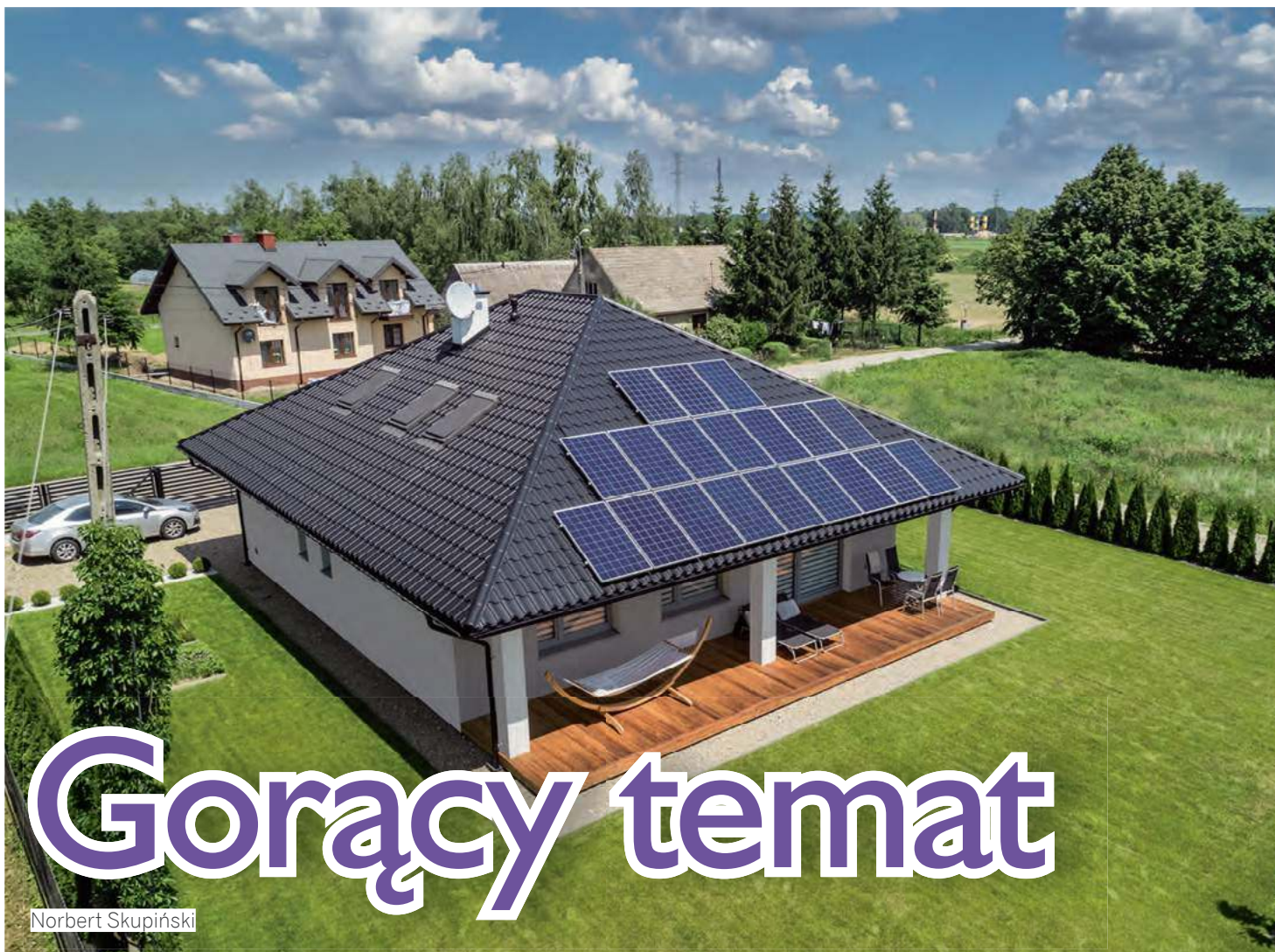
FOT. BRUK-BET FOTOWOLTAIKA
