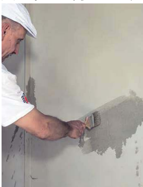
📌 Przed nałożeniem gładzi ścianę się gruntuje. BAUMIT
