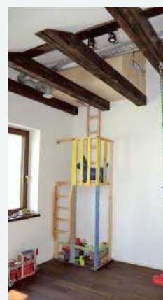
W sypialniach celowo nie obudowano przewodów wentylacyjnych i anemostatów.
