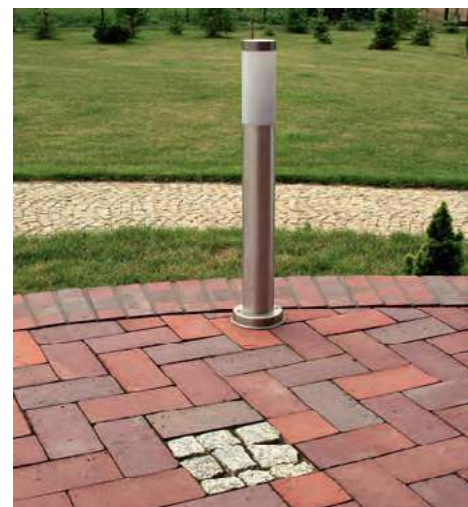
🔗 Kostka klinkierowa jest trwalsza i droższa od betonowej, ale za to nie wymaga impregnacji. LHL KLINKIER
