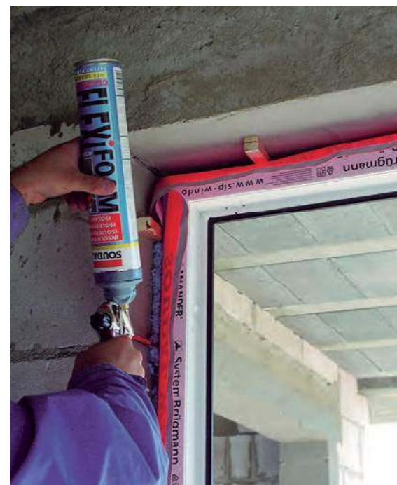
📌 Aby uniknąć mostków na obwodzie okien, miejsca te należy dokładnie wypełnić pianką i dodatkowo ostonić taśmami. Soudal
