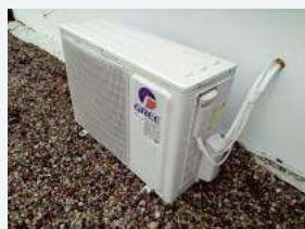
Przewody elektryczne i orurowanie jednostek zewnętrznych.
