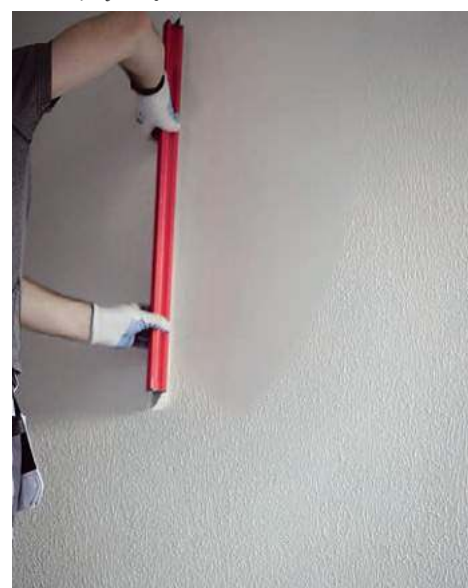
📌 Po nałożeniu gładzi wygładza się narzędziem nazywanym szpachlą.
