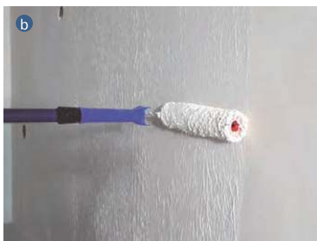
📌 Różne sposoby nakładania gładzi: stalową pacą (a GREINPLAST), wałkiem (b GREINPLAST), maszynowo agregatem (c BAUMIT).
