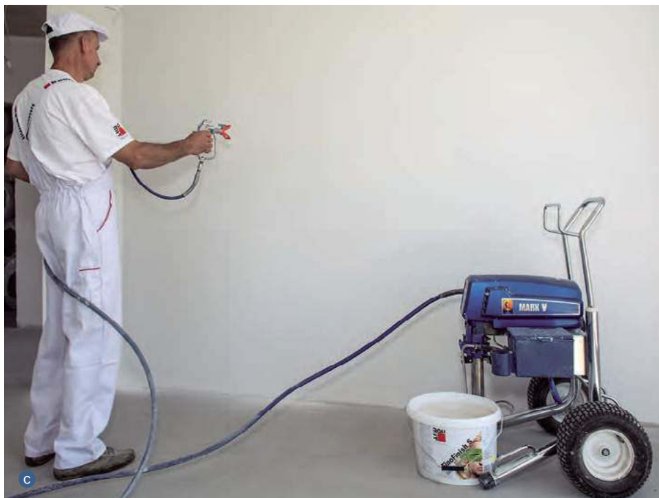
📌 Różne sposoby nakładania gładzi: stalową pacą (a GREINPLAST), wałkiem (b GREINPLAST), maszynowo agregatem (c BAUMIT).
