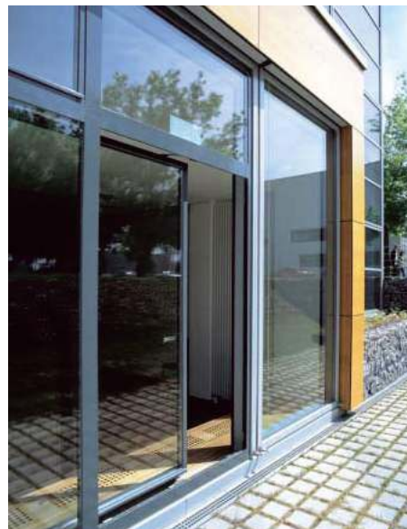
🔗 W przypadku oszklenia dużych fragmentów ścian część skrzydeł warto zaplanować jako nieotwierane (fiksy). G-U POLSKA
