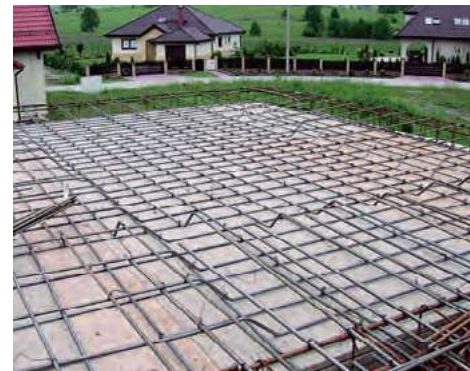
📌 Strop żelbetowy to właściwie stalowa kratownica zalana mieszanką betonową. Wymaga dużego nakładu pracy, ale za to można nadać mu dużą wytrzymałość i dowolny kształt. STALEXSPORT
