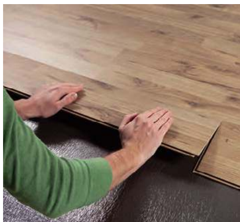
🔧 Panele przeważnie montuje się jako posadzkę pływającą, bez klejenia. HARO
