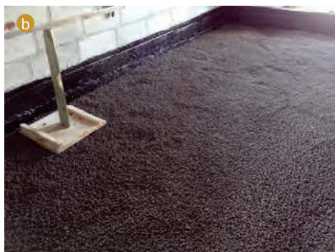
a Podłoga na gruncie zaizolowana styropianem (a A. PAPIŃSKI) i keramzytem (b SAINT-GOBAIN).
