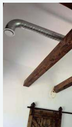
W sypialniach celowo nie obudowano przewodów wentylacyjnych i anemostatów.
