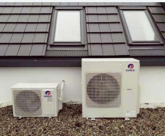
Jednostki zewnętrzne instalacji multisplit i kanałowej.
