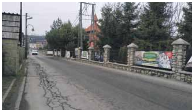
Główny dojazd na Kotelnicę Białczańską. Gmina i policja zastanawiają się co zrobić, aby w tym miejscu usprawnić ruch w sezonie turystycznym.
