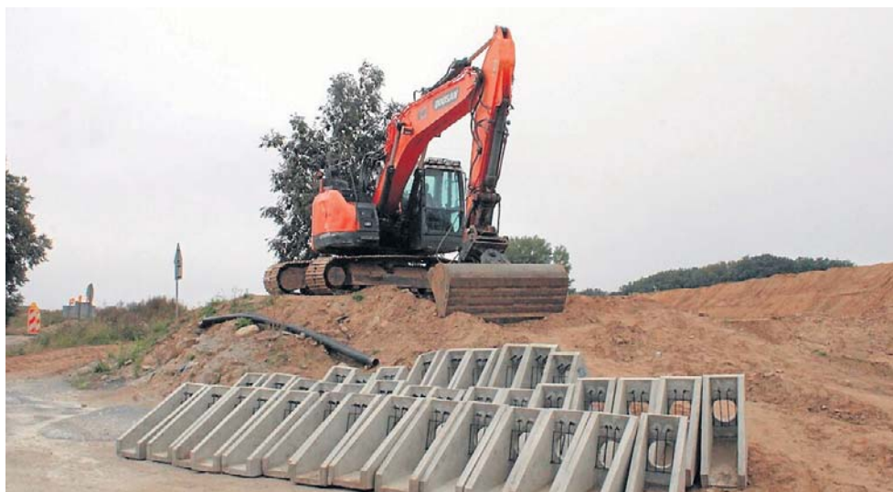
Droga ekspresowa S11 od lat jest jedną z najbardziej oczekiwanych inwestycji drogowych w Wielkopolsce. Budowa trwa, ale w Zachodniopomorskiem
