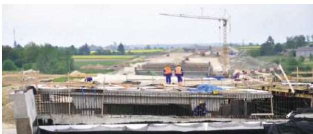
Budowa tego odcinka ma znaczenie dla całego układu komunikacyjnego Zamościa. Fot. GDDKiA
