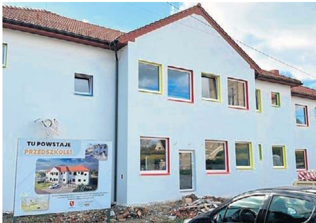
Powstające przedszkole w Królówce jest na etapie prac wykończeniowych
