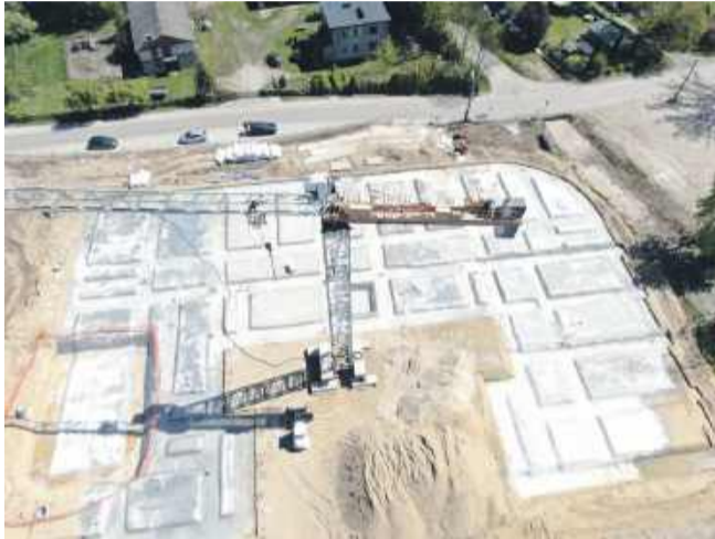
Trwają prace ziemne na terenie budowy
