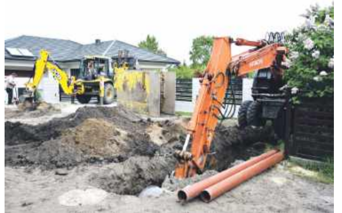
Budowa kanalizacji sanitarnej w Psarach
