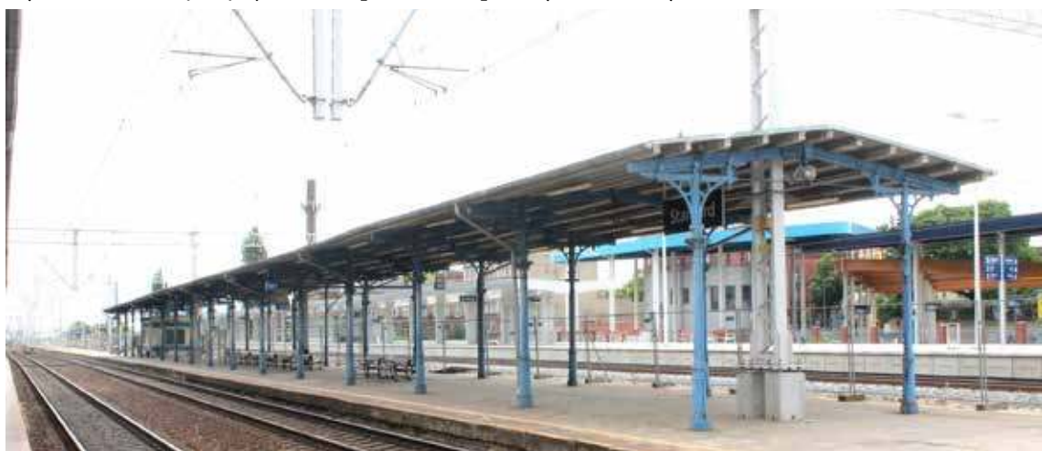
Mieszkańcy chcą, by zabytkowe zadaszenie peronu pozostało na swoim miejscu
