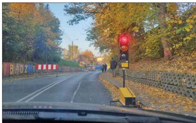
Przed 3 listopada na wspomnianym odcinku drogi obowiązywał ruch wahadłowy
