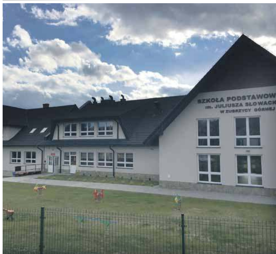
Uczniowie z Zubrzycy Górnej rozpoczęli nowy rok szkolny w wyremontowanym budynku. Będą też ćwiczyć w nowej sali gimnastycznej
