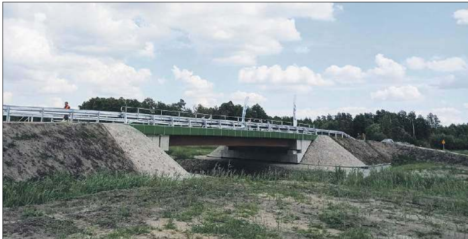
Most w Perkowicach połączył dwie gminy – Zalesie i Biała Podlaska. Uroczyste otwarcie nastąpiło 31 lipca, na wydarzenie przyjechali samorządowcy i wykonawca inwestycji
