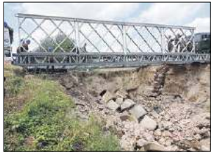
Most zamontowali saperzy z 1 Dęblińskiego Batalionu Drogowo-Mostowego
