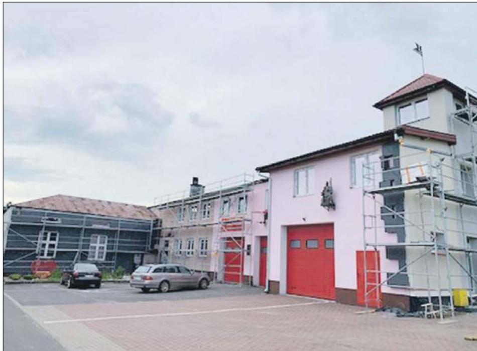
Trwa generalny remont Gminnego Centrum Kultury i biblioteki
