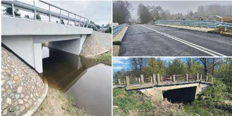
Zrealizowane inwestycje oraz zadania będące w przygotowaniu pokazują rozwój infrastruktury drogowej.
