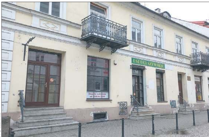
Rozpoczyna się przebudowa kamienicy przy ul. Grodzkiej 8
