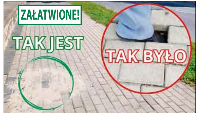
Dziura w chodniku na ul. Prudnickiej została naprawiona.
