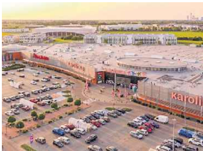
Przebudową będzie objęta spora część galerii, od wejścia głównego po wejście w strefę gastronomiczną.
