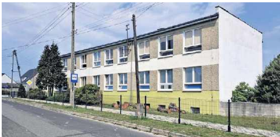
Całkowity koszt modernizacji szkoły wynosi prawie 1,5 miliona złotych.
