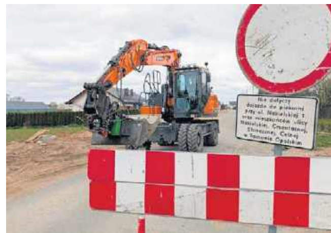
Jezdnia zostanie poszerzona do 5,5 m, powstanie nowoczesna droga pieszo-rowerowa o szerokości ponad 3 m.
