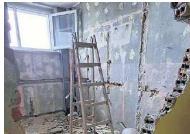
W środku trwa wymiana okien, instalacji elektrycznej, sieci grzewczej oraz sanitariatów. Będzie też nowy piec.
