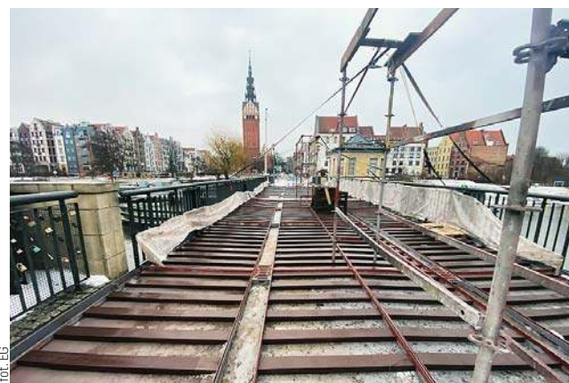
Na Moście Wysokim zostanie zastosowana taka sama technologia jak na wcześniej wyremontowanym Moście Niskim
