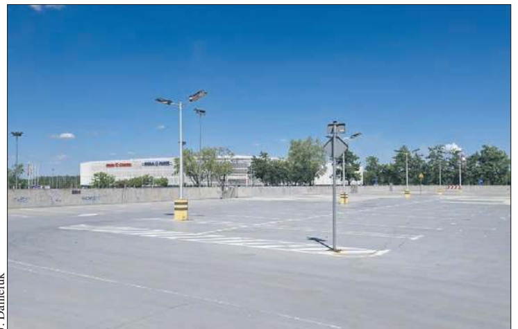
Parking przy ORLEN Arenie wymaga remontu
