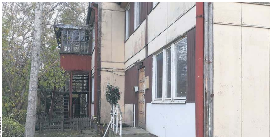
Na osiedlu Miodowa Jar do wyburzenia pozostało jeszcze sześć budynków. W przyszłym roku nowy blok zastąpi wysłużony obiekt pod numerem 47
