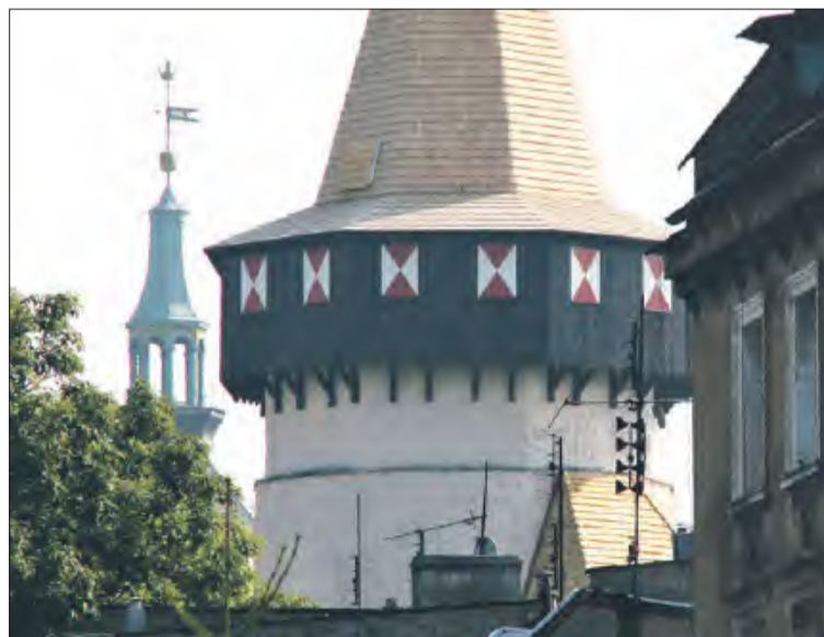
Wieża Woka jest unikatowym obiektem architektury średniowiecznej, uznawaną za najstarszą wieżę zamku prywatnego w Polsce (XIII w.).
