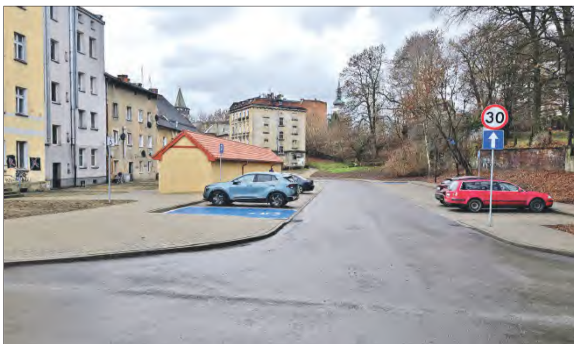
Największa zmiana przy ul. Chrobrego, to całkowita przebudowa zaplecza kamienic od strony ul. Ogrodowej. Dawniej było tu skupisko starych komórek, a przy okazji śmietniko i zniszczona, wybrukowana kocimi łbami alejka.
