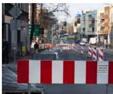
Przy okazji przebudowy ul. Konopnickiej robotnicy wykonują remont ulicy Żeromskiego
