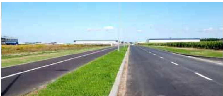
Ulica Metalowa zostanie wydłużona, ponadto powstanie ciąg pieszo-rowerowy, chodnik oraz zatoka autobusowa.
