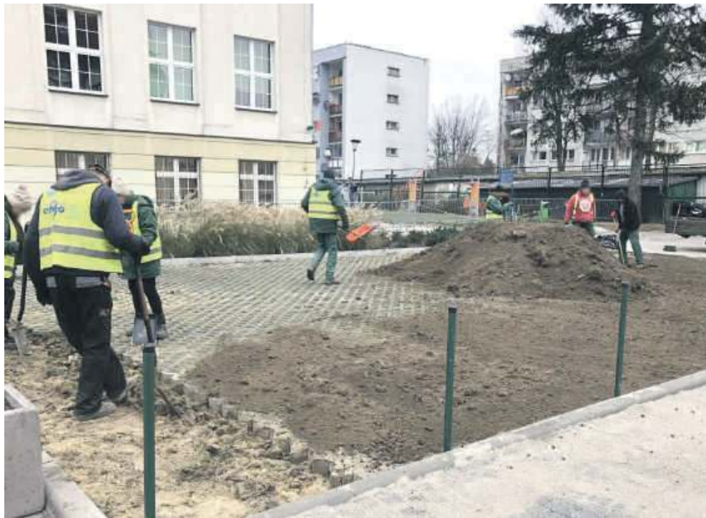
Tak pracownicy gminnej spółki komunalnej Ergo zasypywali ułożoną wcześniej ażurową kostkę betonową przed Szkołą Podstawową nr 1 w Trzebnicy. Gdy zapytaliśmy o koszty i dokumenty, odpowiedzi nam nie udzielono. Zrobiono to dopiero wtedy, gdy sprawa trafiła do prokuratury
