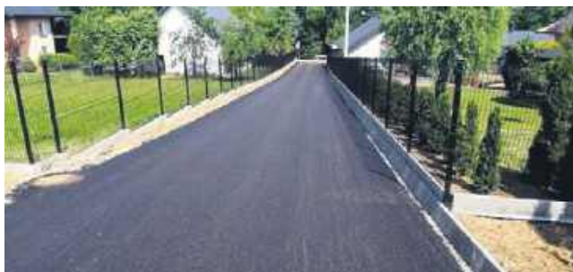
Droga Łososina Dolna-Jarostowa
