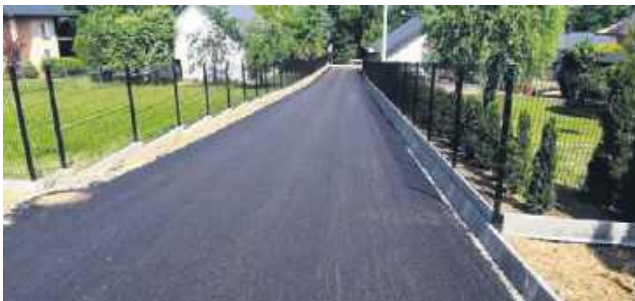
Droga Łososina Dolna-Jarostowa
