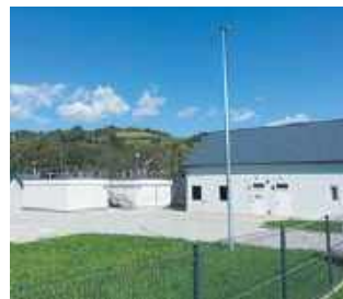
Stacja uzdatniania wody
