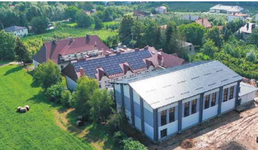
Budowa sali gimnastycznej w Czarnym Potoku
