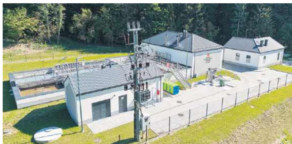
Oczyszczalnia ścieków w Łęce
