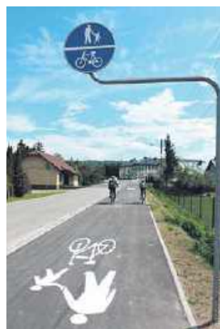
Wybudowano wiele odcinków ścieżek pieszo-rowerowych. Powstają kolejne.
