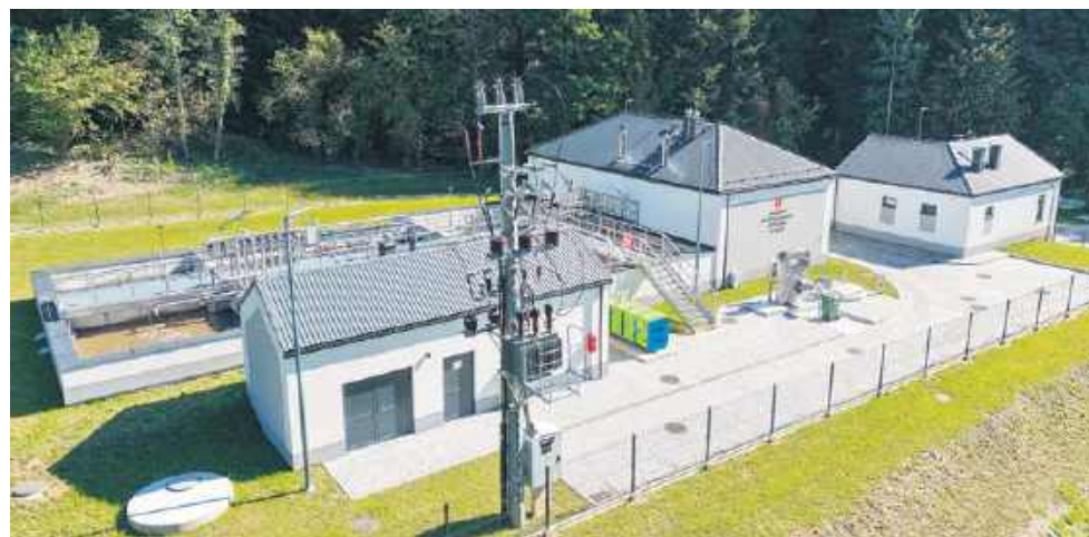
Oczyszczalnia ścieków w Łęce
