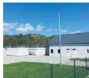
Stacja uzdatniania wody
