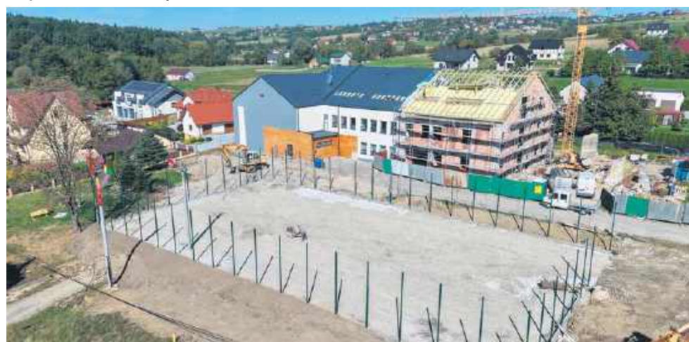
Rozbudowa szkoły i budowa boiska w Łęce
