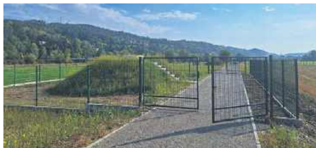
Ujęcie wody w Witowicach Dolnych
