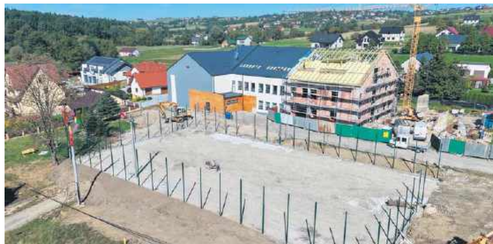
Rozbudowa szkoły i budowa boiska w Łęce
