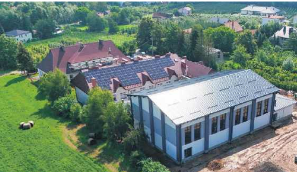
Budowa sali gimnastycznej w Czarnym Potoku
