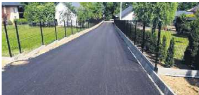
Droga Łososina Dolna-Jarostowa
