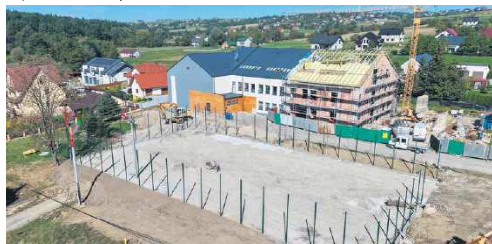
Rozbudowa szkoły i budowa boiska w Łęce
