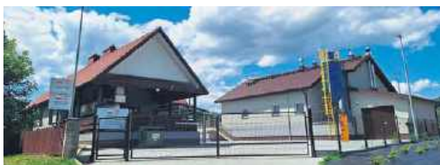
Oczyszczalnia w Tęgorz
