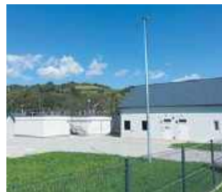
Stacja uzdatniania wody
