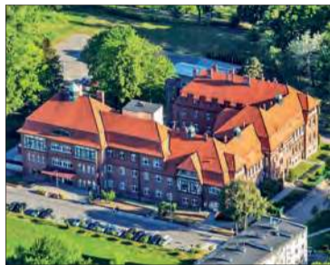
Nieużytkowany budynek na zapleczu szpitala przekształcony zostanie m.in. na poradnie specjalistyczne
