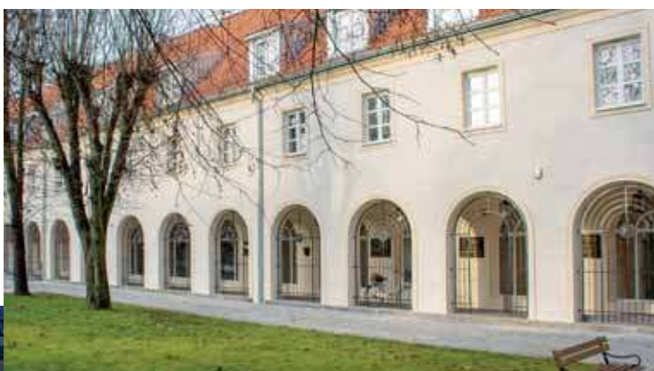
Krzywa Hala po renowacji
