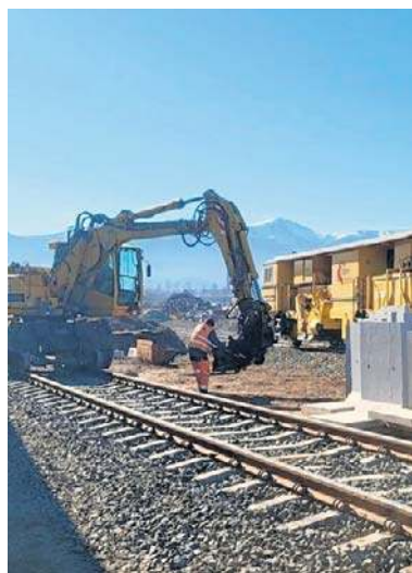
Województwo dolnośląskie wyremontowało m.in. linię kolejową Jelenia Góra – Karpacz
