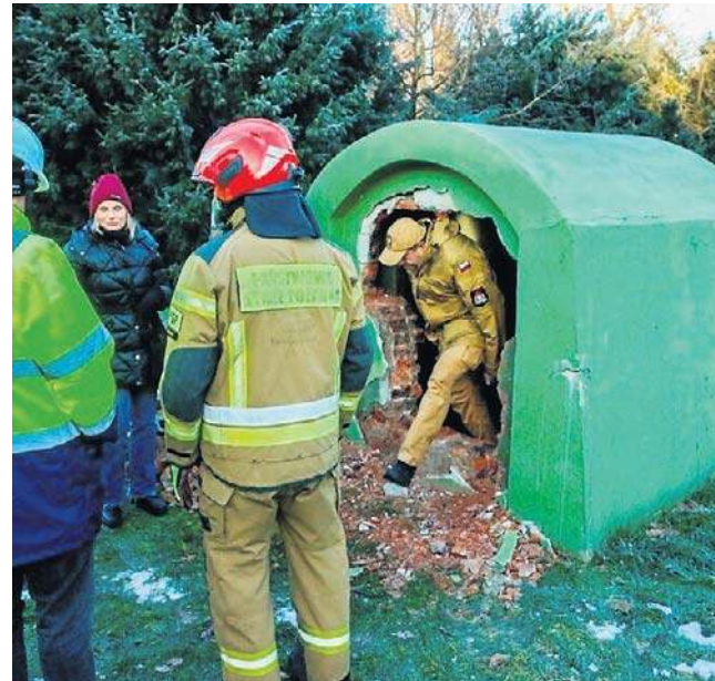
Wejścia zamurowano wiele lat temu, teraz je rozkuto
