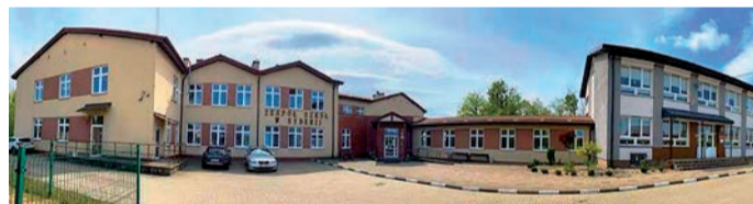
W tym obiekcie przebuduje się schody wejściowe i zmodernizuje się kotłownię
