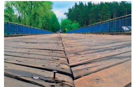
Powiat przygotowuje się do budowy nowego mostu
