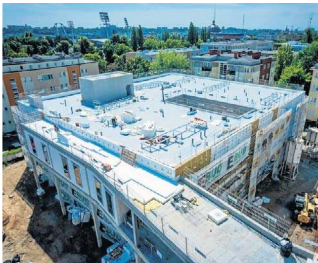
Budowa Ośrodka Diagnostyki Narządowej ruszyła w maju 2025 r.
