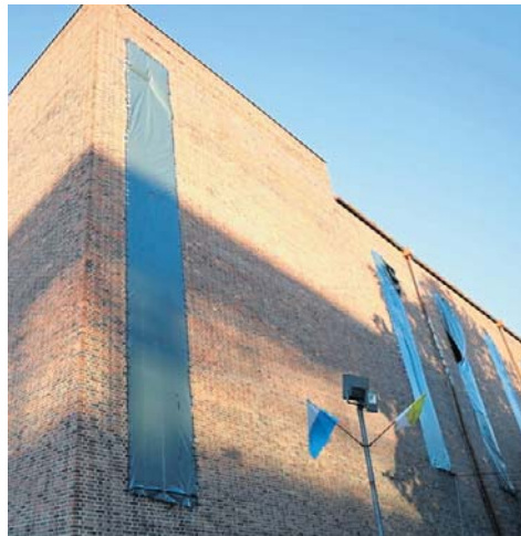
Na potrzeby filmu już zakleiono okna
