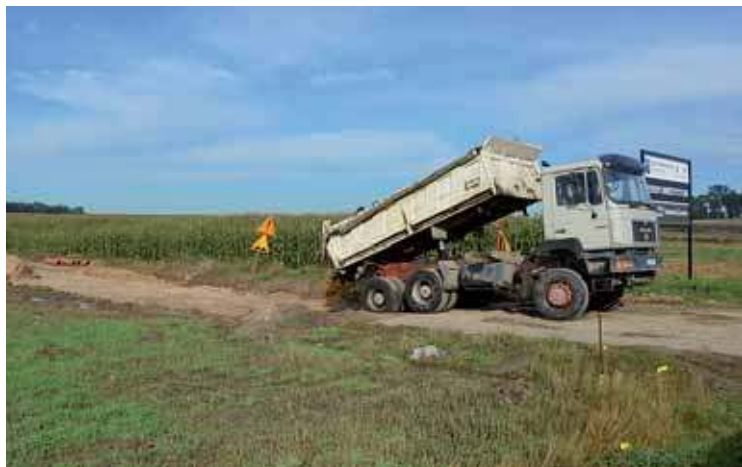
Trwa budowa nowej drogi w Żurominie
