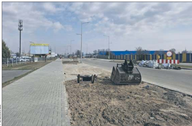
Trwa remont ulicy Przemysłowej
