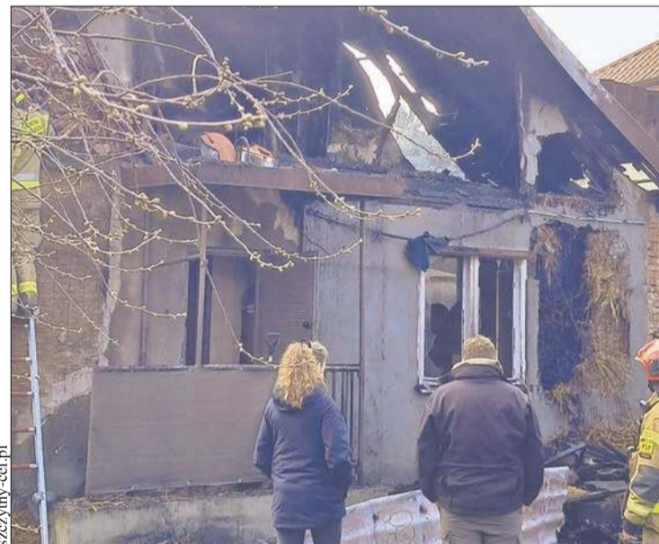
Z domu przy ul. Fabrycznej 16 zostały tylko zgliczysza
