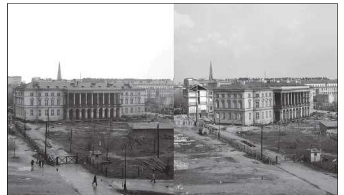
■ Etapy przesuwania bryły pałacu Lubomirskich
