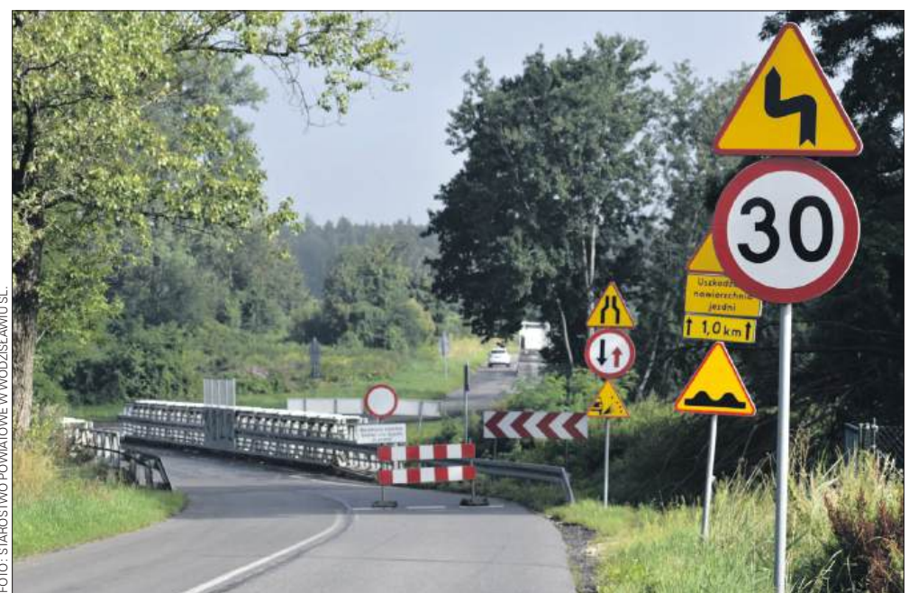
■ Utrudnienia w ruchu są spowodowane remontem drogi
