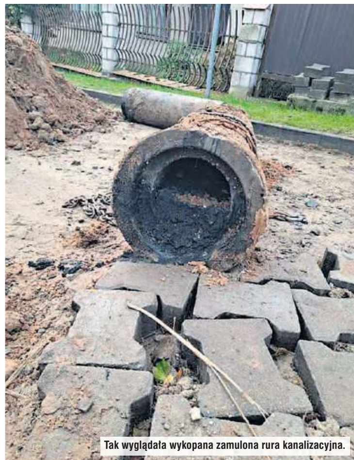
Wymiana rur kanalizacyjnych na ulicy Półkole w Gostycynie. Fot. nadesłane
