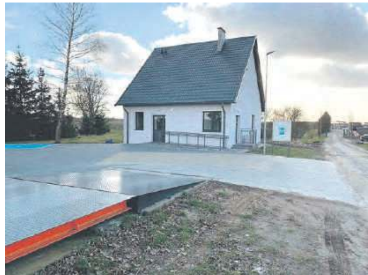
Budowa infrastruktury PSZOK-u w Bystawiu pochłonęła 1.146.000 zł, dofinansowanie z UE wyniosło 791.951,22 zł. Fot. UG Lubiewo
