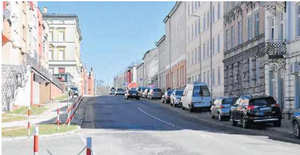
Ulica Młyńska nie będzie przebudowywana, ale zostanie solidnie wyremontowana. Nie pojawi się więc tutaj ścieżka rowerowa
