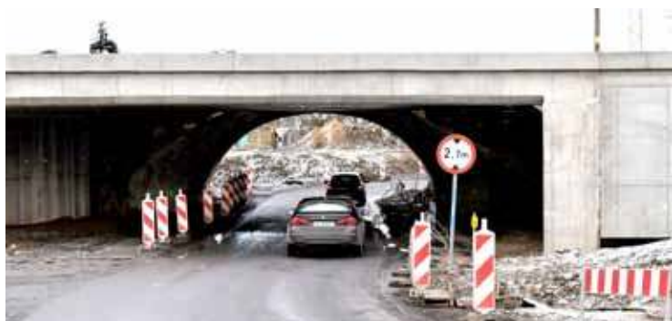
Od początku stycznia otwarty jest przejazd pod wiaduktem na ul. Składowej
