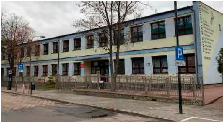
Po przebudowie na parterze VII LO przy ul. Farbiarskiej powstanie przedszkole
