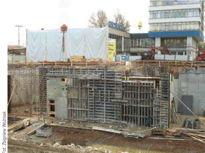
Nowy dworzec ma być gotowy na początku 2024 roku
