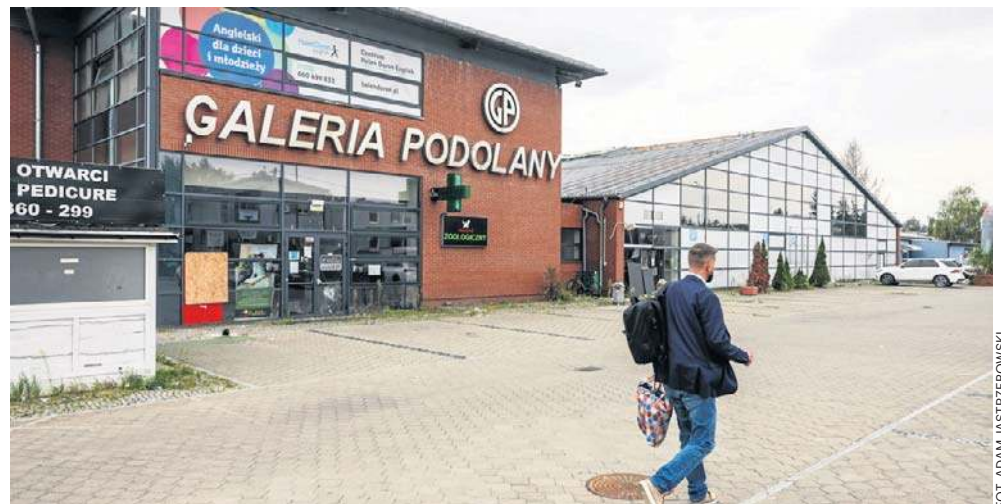
Galeria Podolany pozostaje zamknięta. Trwają badania konstrukcji, które pokażą, czy budynek da się wyremontować, czy trzeba będzie go wyburzyć
